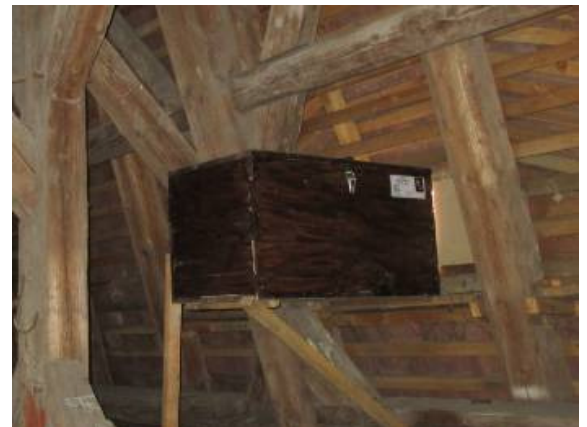
Nistkasten am Hechtaugenfenster im Dachgeschoß des Abteigebäudes
