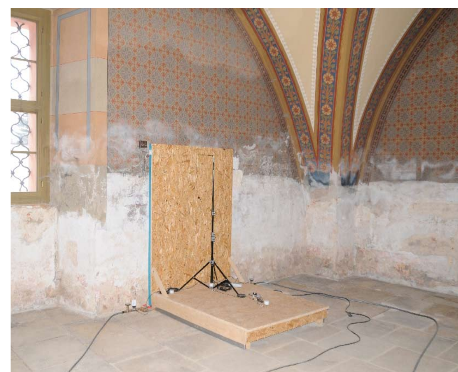
Abb. 10: Sakristei: Musterpodest zur Klima-Messung
